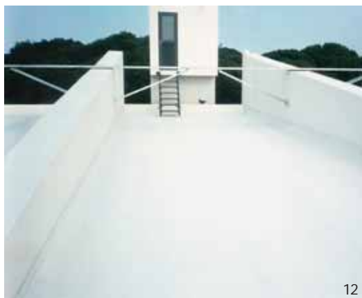
12 y 13 Cubierta finalizada, SikaTop Seal 107 y Membrana Asfáltica Sika – 42TP pintadas con Sikaguard Acryl color arena.
