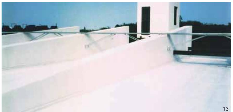
12 y 13 Cubierta finalizada, SikaTop Seal 107 y Membrana Asfáltica Sika – 42TP pintadas con Sikaguard Acryl color arena.
