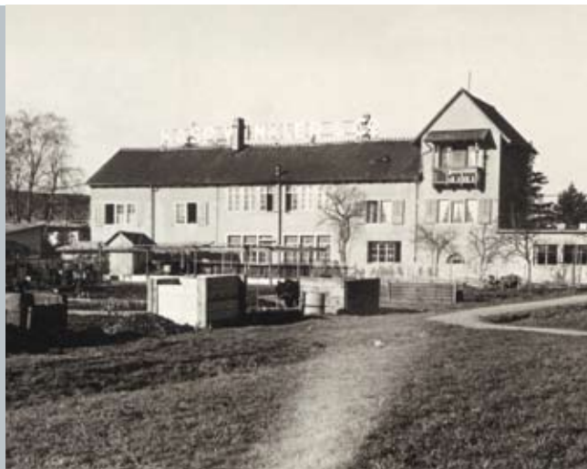
Almacén y fábrica de una sola planta con chimenea, construida en 1919 junto a la residencia de la familia Winkler en Geerenweg, Suiza.
